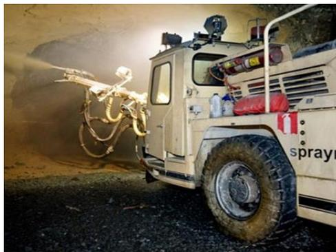
Figura 4 – Equipamento Spraymec na projeção de projeto
