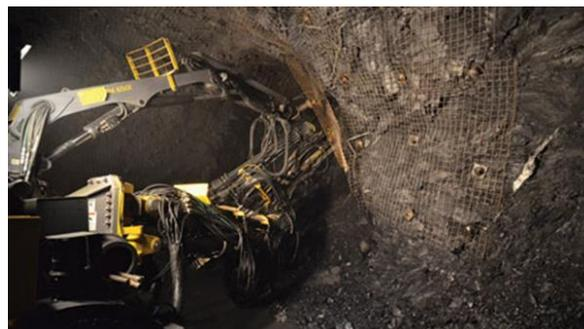
Figura 6 – Sistema tela metálica
