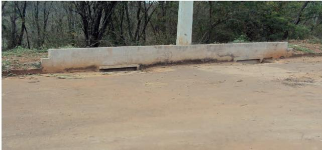
Figura 19 – Área com barreira para evitar erosão pluvial.
