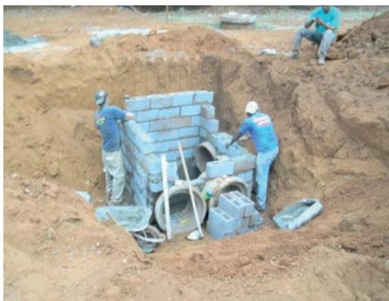
Figura 6 – Execução de poço de visita de águas pluviais.
