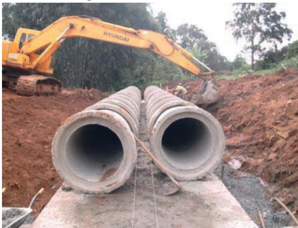
Figura 12 – Alinhamento dos tubos de concreto.
