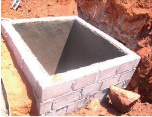
Figura 7 – Poço de visita executado e impermeabilizado internamente.
