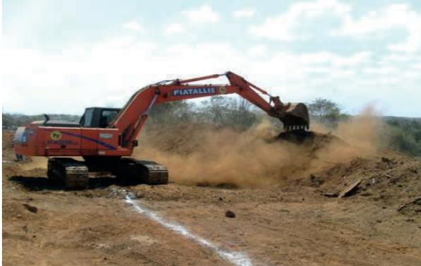
Figura 3 – Escavação da rede de águas pluviais.
