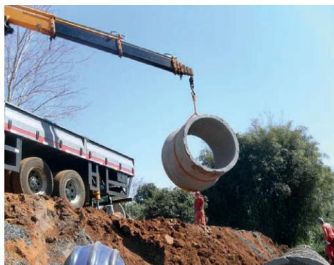
Figura 17 – Adição de tubo de concreto à canalização.
