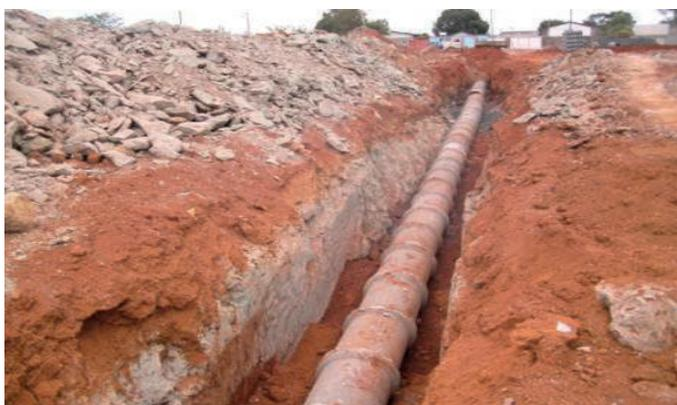
Figura 5 – Rede mestra de águas pluviais.
