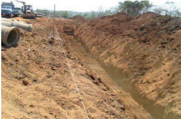
Figura 4 – Rede pluvial escavada.
