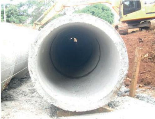
Figura 14 – Rejuntamento interno dos tubos.
