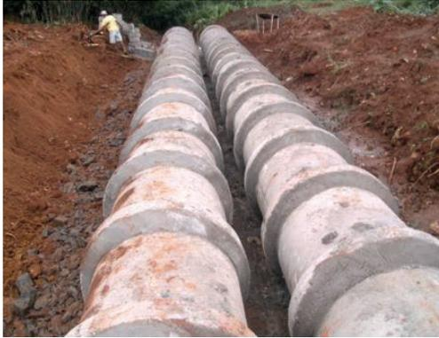
Figura 13 – Rejuntamento externo dos tubos.
