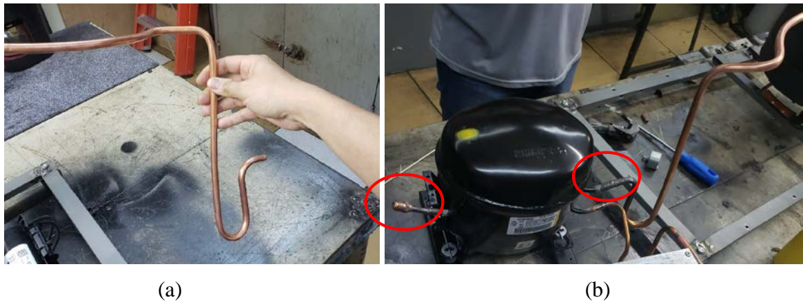
Figura 11 – Unidade condensadora. a) Confeção de sifão. b) Soldagem de válvula shradar
