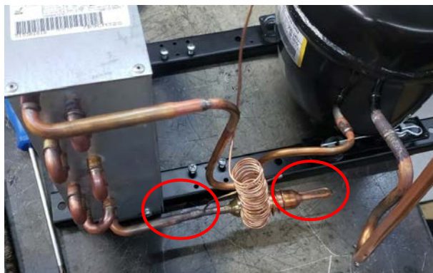
Figura 12 – Soldagem do filtro secador e tubo capilar
