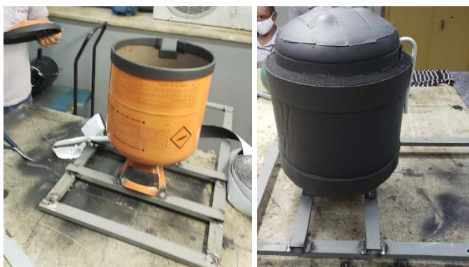
Figura 13 – Corte da tampa, soldagem do cilindro na base metálica e isolamento térmico
