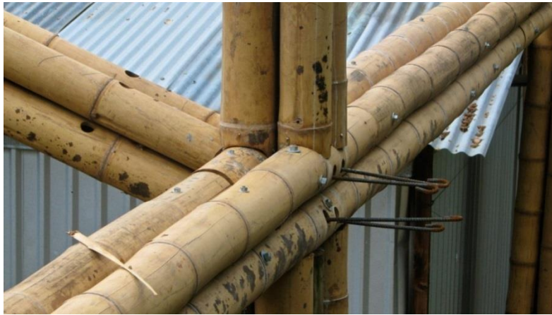
Figura 9 - Exemplo de ligação - viga e pilar
