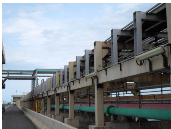
Foto 04 – Visão geral Pipe Rack
