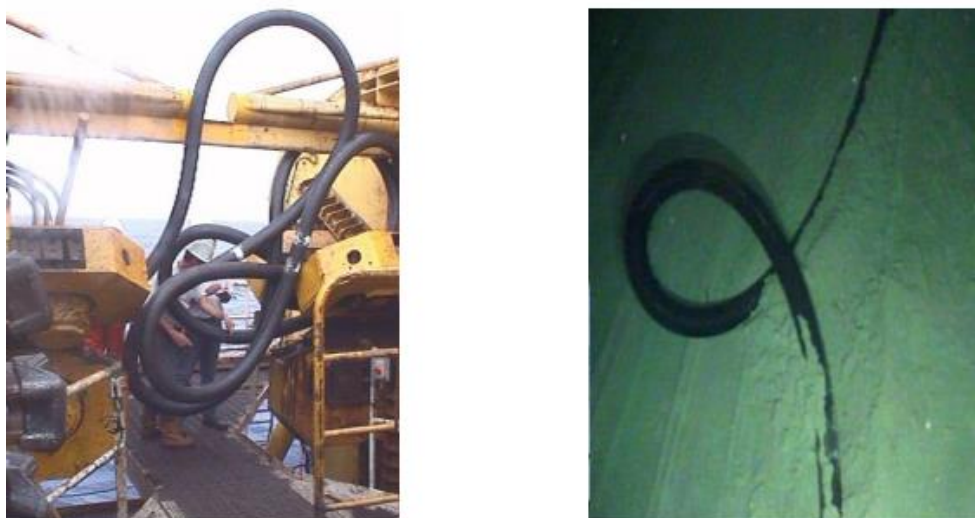
Figura 25: Looping em flexível durante carregamento e lançamento
