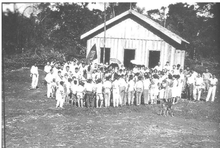
Figura 1- Escola construída no córrego do Anacleto – 31/3/1962
