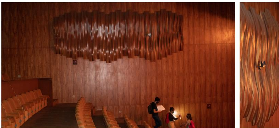
Figura 3 – Painel de madeira – autoria Athos Bulcão – perfurado para instalar iluminação de emergência (fonte: acervo particular dos autores).
