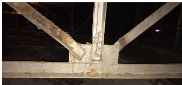
Figura 18: Ligação através de soldagem direta in loco . Fonte: acervo particular dos autores.
