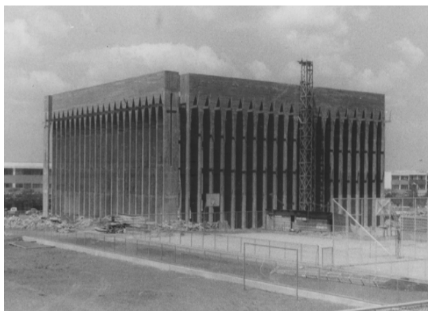
Figura 2: Foto da vista externa – sem identificação de data. Fonte: acervo do SDB.
