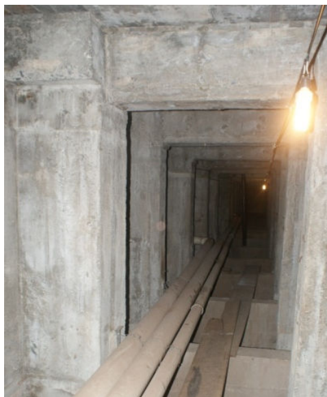
Figura 7: Vista da parte interna do corredor de serviço. Fonte: acervo particular dos autores.
