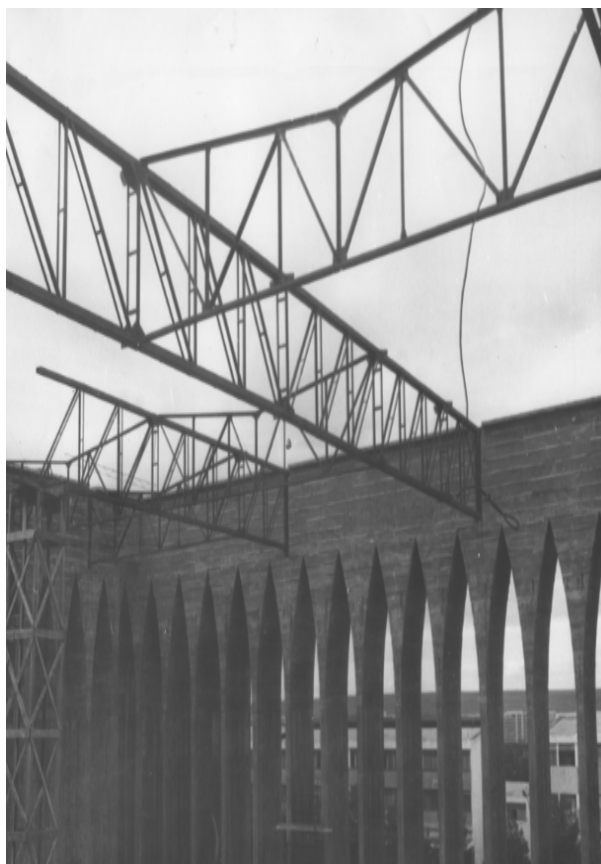
Figura 8: Vista da montagem das treliças do telhado. Fonte: acervo do SDB.
