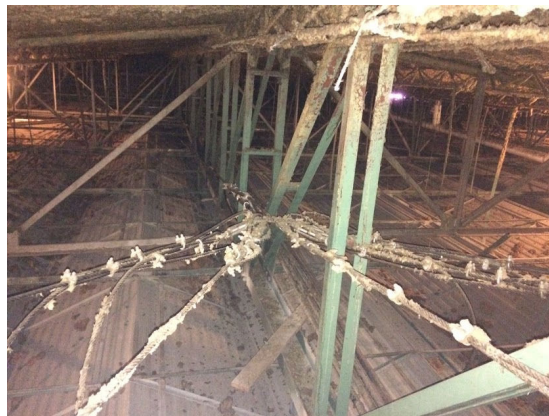
Figura 17: Vista atual do telhado, treliça modelo 1 e treliça modelo 2 cruzadas perpendicularmente. Fonte: acervo particular dos autores.
