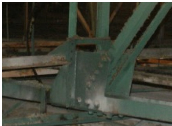
Figura 21: Ligação aparafusada in loco . Fonte: acervo particular dos autores.
